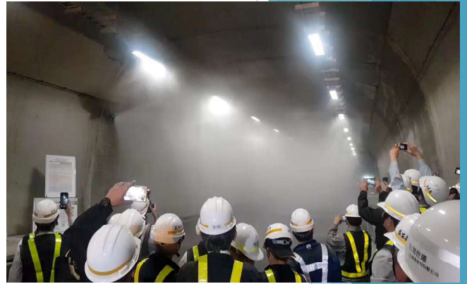
隧道建置水霧系統，可先期壓制火勢
